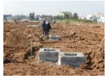
le chantier des 1000 bungalows
